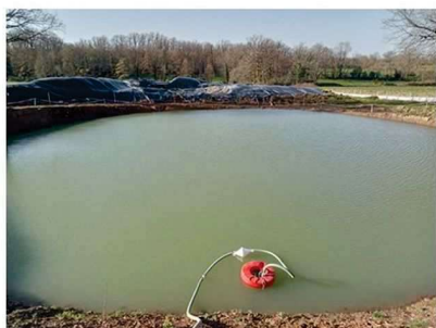
Eolienne E1 (à gauche) fondation en eau ; (au centre) mise en place de la station de pompage ; (à droite) barrière anti-amphibiens
