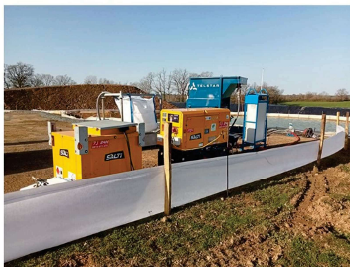
Eolienne E2 (à gauche) fondation en eau ; (à droite) station de pompage
