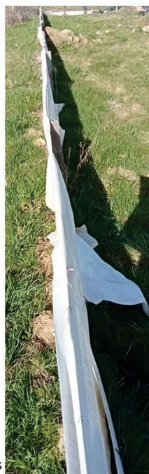
Zones défectueuses de la barrière anti-amphibiens
